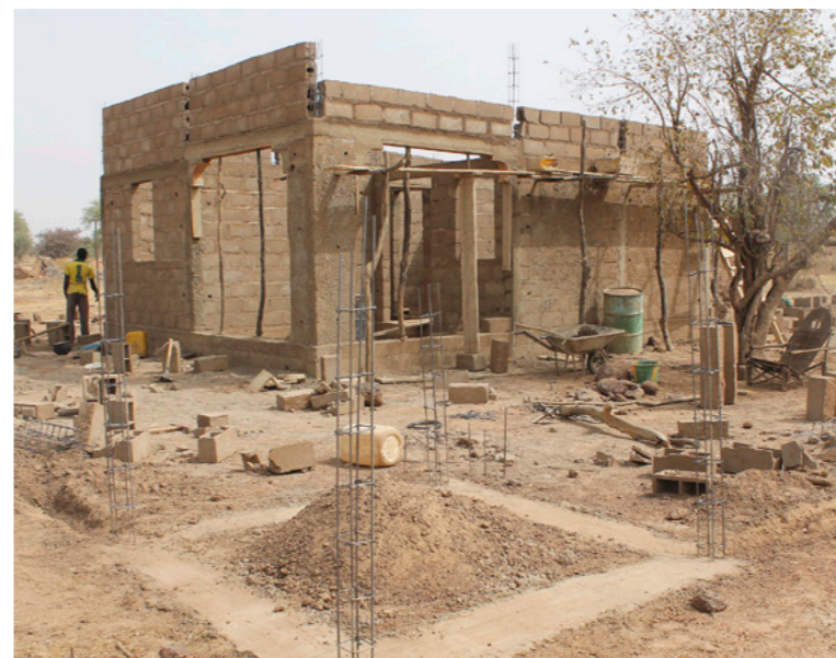
Lehrerwohnung im Bau
