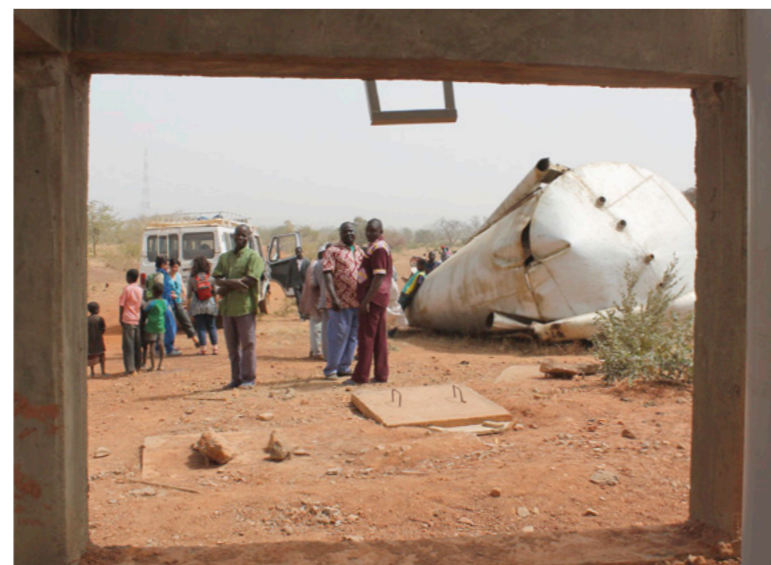
Blick durch den neuen auf den alten, umgestürzten Wasserturm
